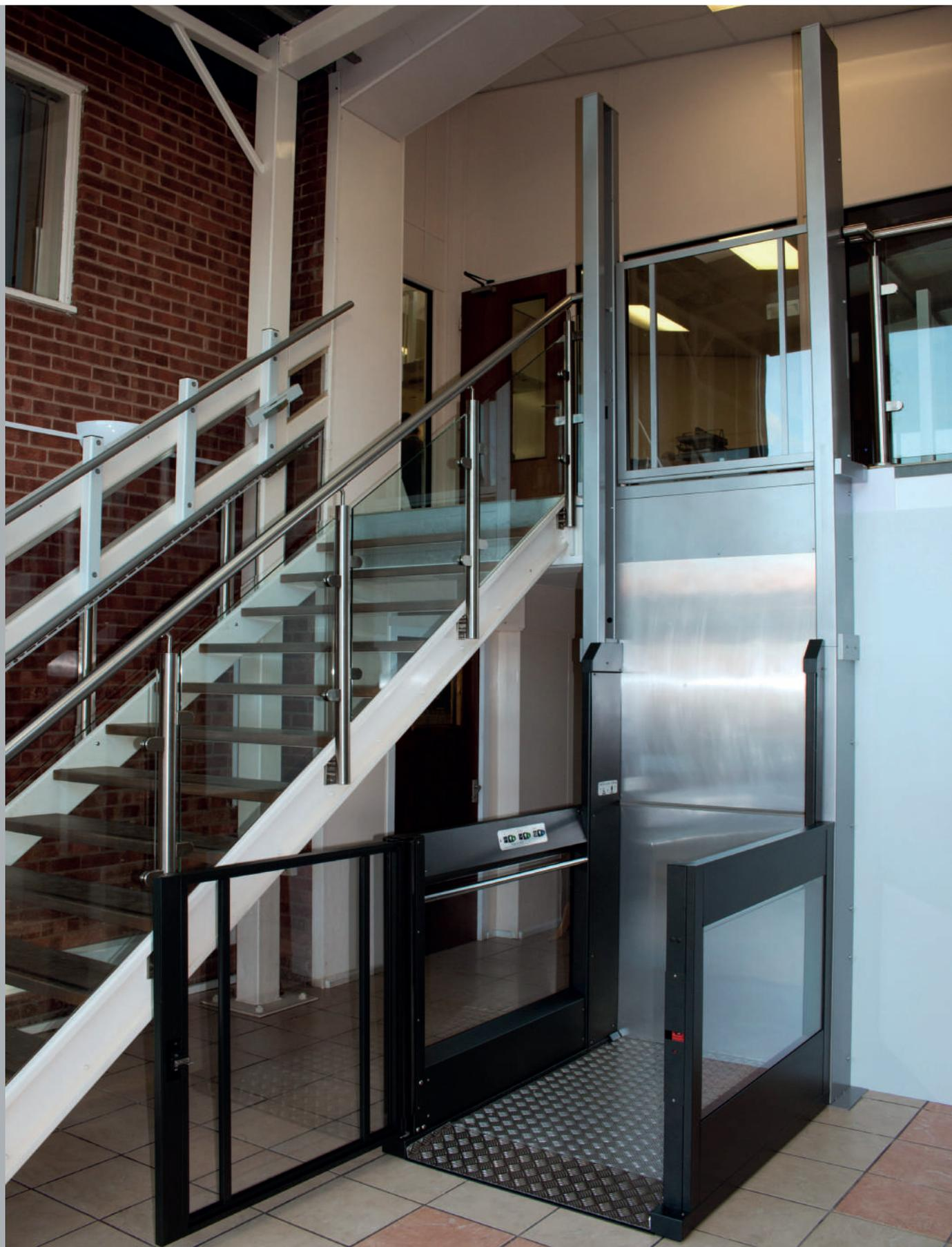
Smart 2000 e Smart 3000 sono le soluzioni per il superamento di dislivelli fino a 3 metri di altezza che rispondono alle legislazioni in tema di abbattimento delle barriere architettoniche.
